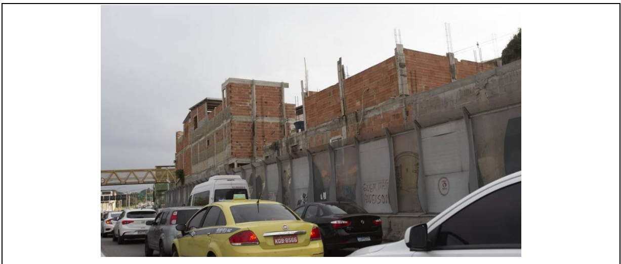
Figura 4: Construções de até três andares junto à proteção da Linha Amarela, na altura da Maré: favelas em volta da via cresceram 2,7% em dez anos Foto: Alexandre Cassiano / Agência O Globo.
